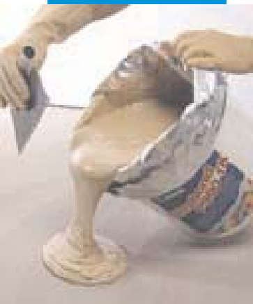
Lití lepidla na podkladovou vrstvu
