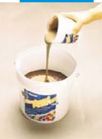
Přidávání tvrdící přísady (složka B) do lepicího tmelu (složka A)
