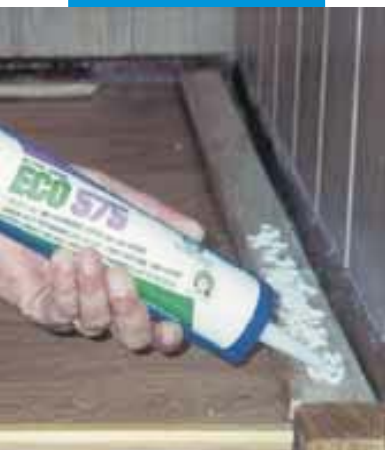
Lepení dřevěného profilu pomocí Ultrabondu Eco 575
