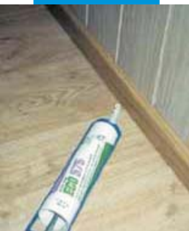
Dřevěný profil přilepený Ultrabondem Eco 575
